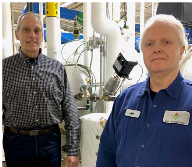
Rick Ouwenga (g) et Jim Leenerman (d) avec respectivement la 7010 et la 7020 : « Ces vannes nous procurent de multiples avantages économiques, tant au niveau du procédé que des coûts d'exploitation et de maintenance ».
