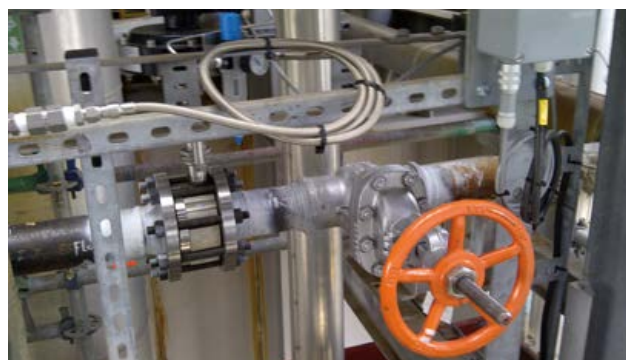
Fig. 6 La nouvelle vanne à glissières avec positionneur 8049.
