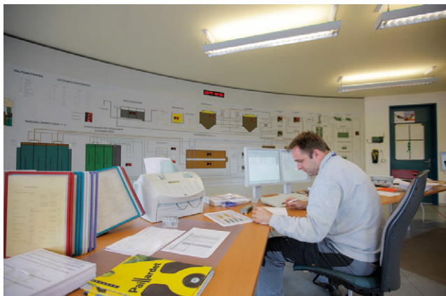
Poste de commande de la STEP Flos, Wetzikon
