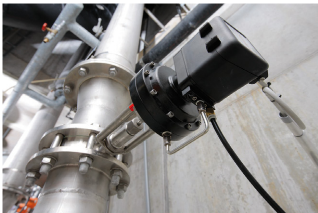
Vanne à glissières coulissantes pour la régulation du taux d'oxygène dans un réacteur biologique.
