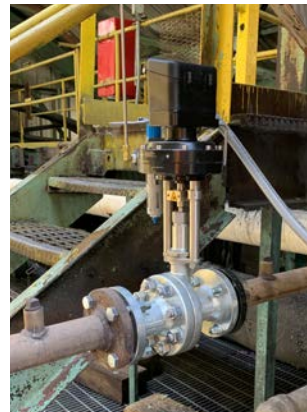
Das Gleitschieberventil Typ 8621 mit Flanschanschluss im Einsatz in der Dampfleitung bei U.S. Vanadium. Die Baulänge entspricht der eines Sitzkegelventils der gleichen Nennweite.
